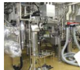
ろ過・乾操作業室
