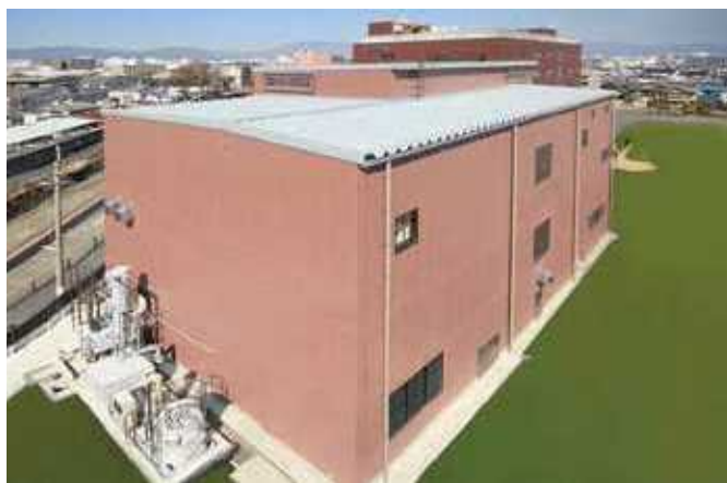
2016年に完成した 治験原薬製造棟
