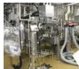
ろ過・乾操作業室
